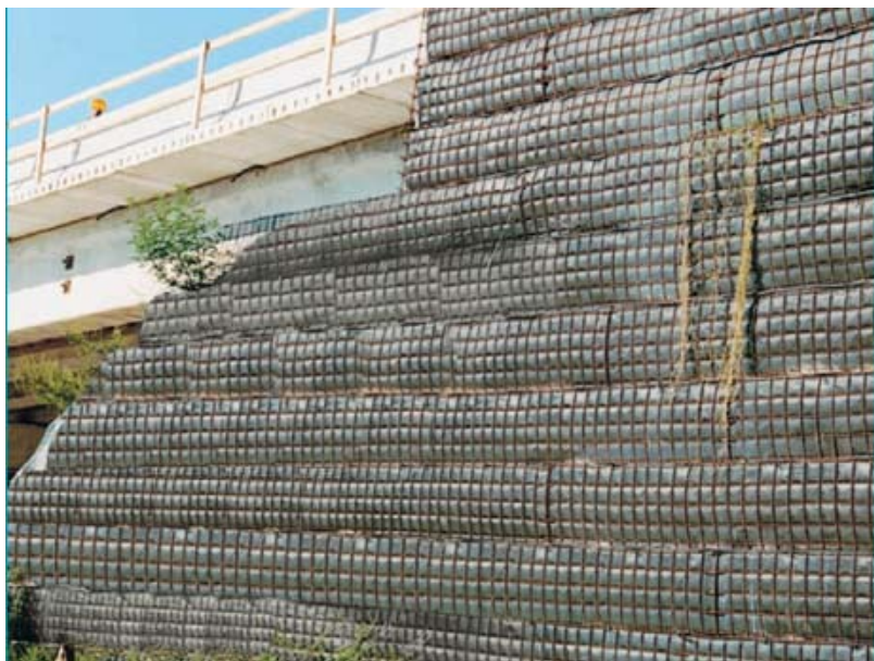
图 2 公路桥头过渡段返包式加筋土挡墙
