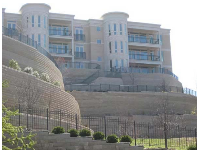
图 2 台阶式加筋土挡墙工程实例
