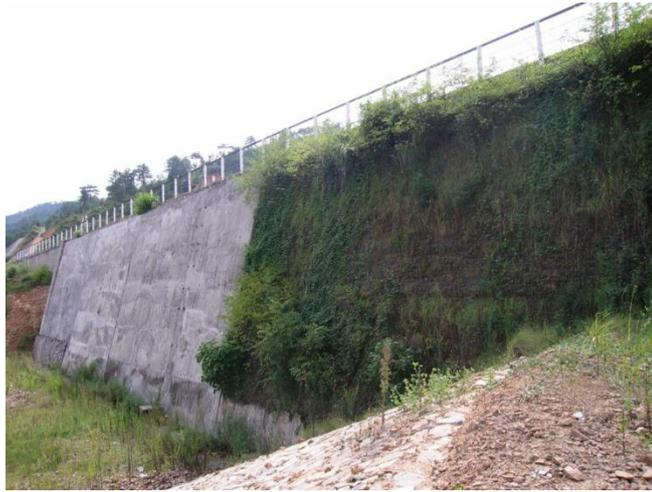
赣龙铁路加筋土挡墙（钢筋砼整体面板 VS 返包式面板）
