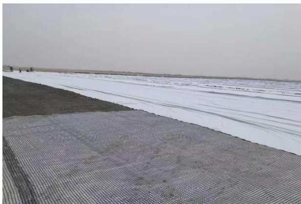
经编涤纶土工格栅施工
