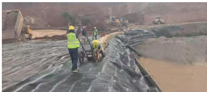
四向塑料土工格栅施工
