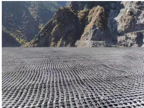
经编玻纤土工格栅施工
