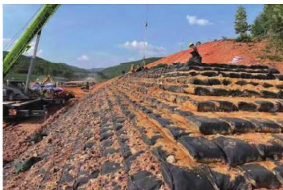
图 3 宁明某膨胀土路堑边坡的土工袋护坡现场图
