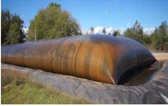
图 7 土工管袋淤泥脱水
