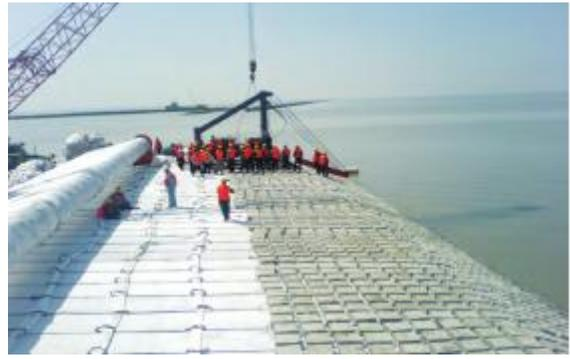
图 8 加筋充泥管袋在长江岸线
