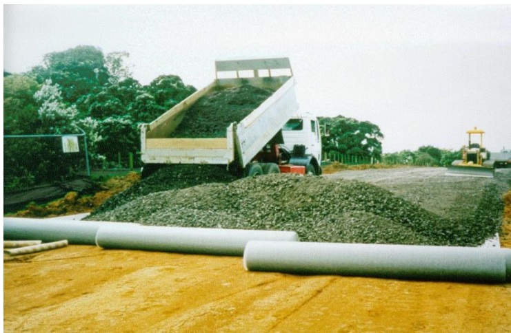
道路隔离层施工
