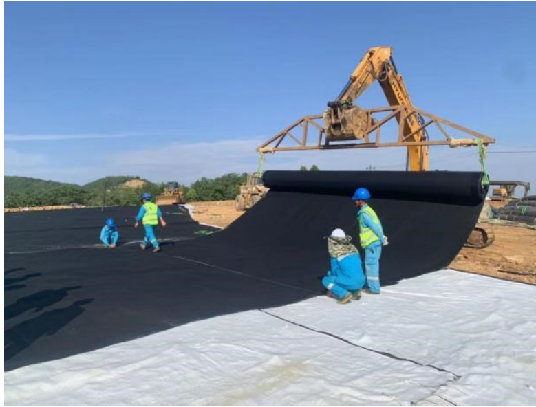
图 2 铺设水平防渗层
