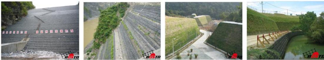
2. 聚丙烯高强单向格栅：具有高强度、高模量、耐老化、耐酸碱和耐微生物等性能，主要应用于软基修筑路堤、铁路道床。
