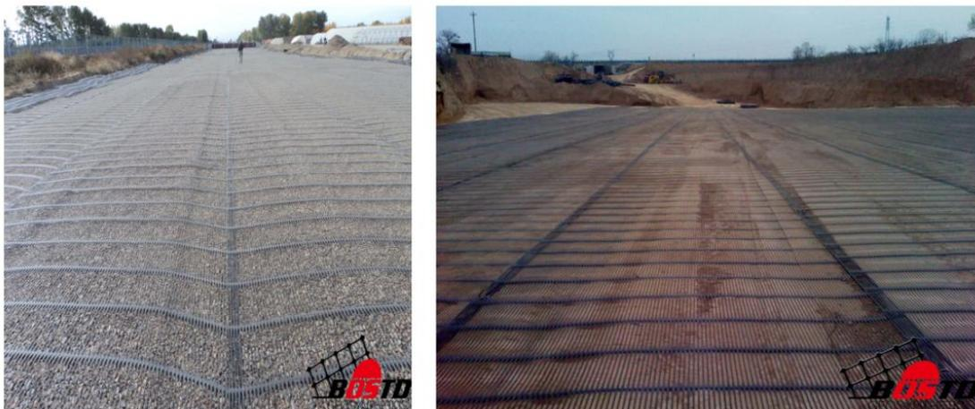
3. 土工格室：具有优异的抗拉强度、焊缝抗剥离强度和耐久性，被广泛应用于垫层、软基处理、管道及下水道的支撑结构，以及沙漠、海滩和堤岸的治理等工程。
