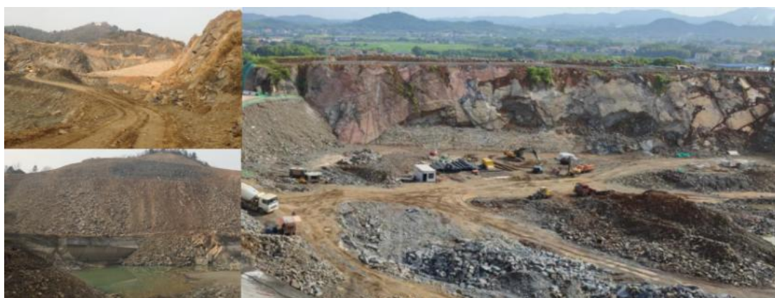
施工前库区一角原貌图
