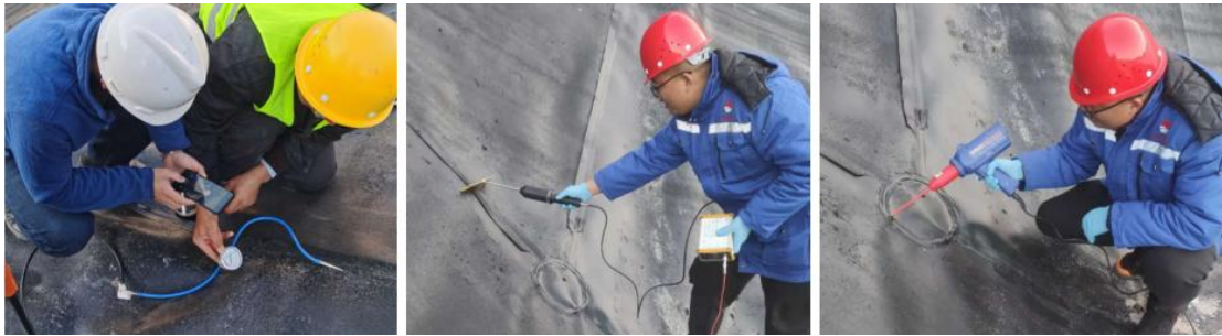
土工膜焊缝检测
