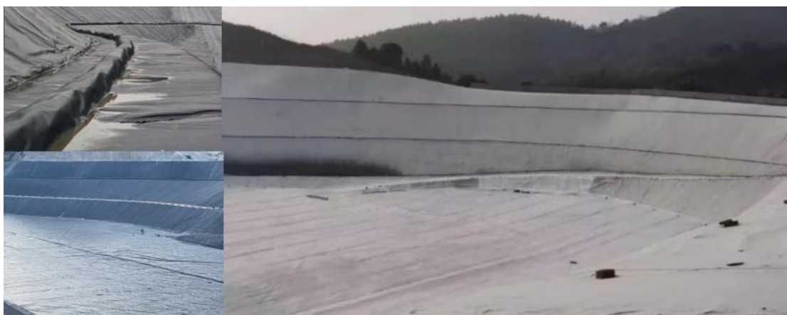
施工后库区一角完工图
