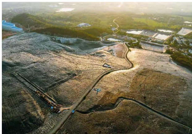
LLDPE 土工膜在垃圾填埋场中的应用
