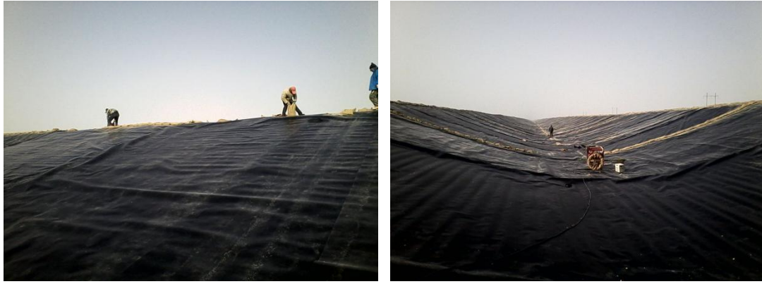
国投罗钾（新疆罗布泊）HDPE 膜项目施工现场
